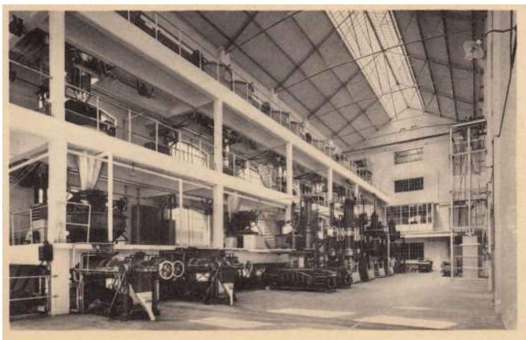
Prentbriefkaart fabrieken Remy Wijgmaal, uitgeverij Nels, Photo E. Sergysels, Bruxelles, niet gelopen. Deze indrukwekkende technische installaties bevonden zich in de fabricatiehal voor voedingspasta.
