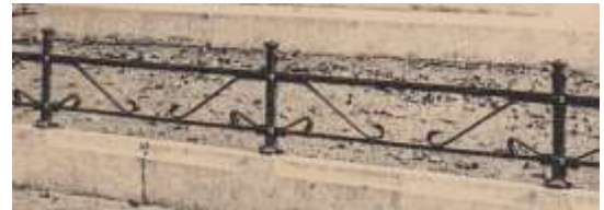
Detail hekwerk art nouveau stijl
